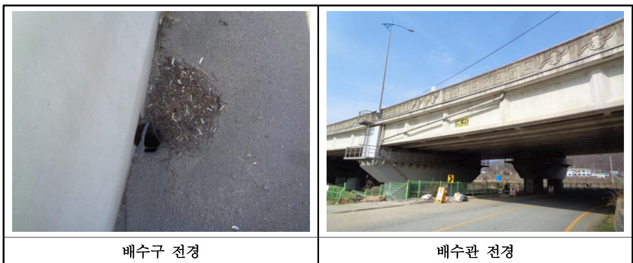
【사진 2.3.19】 배수시설 전경
