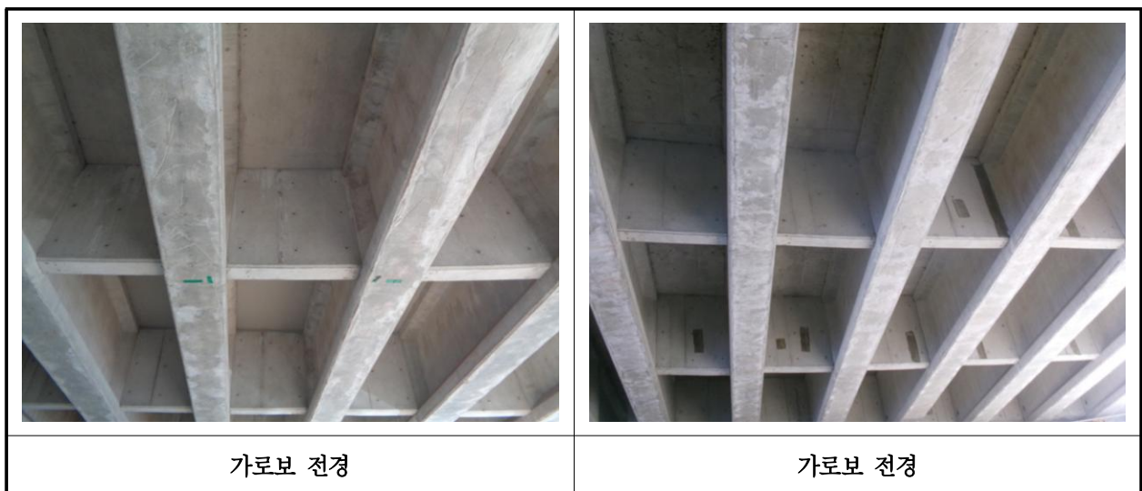
【사진 2.3.6】 가로보 전경
