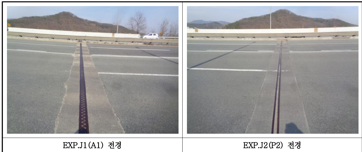
【사진 2.3.14】 신축이음장치 전경
