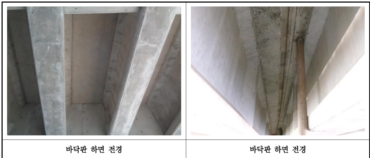
【사진 2.3.2】 바닥판하면 전경
