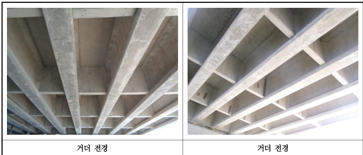
【사진 2.3.4】 거더 전경
