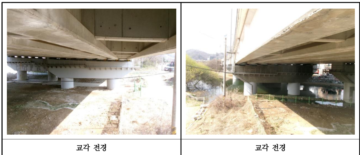
【사진 2.3.10】 교각 전경
